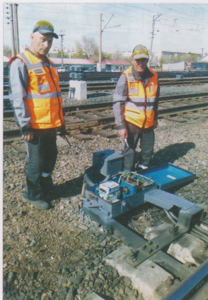
Электромеханик А.П. Шульпин и электромонтер П.Ю. Иванов проверяют внутреннее состояние электропривода на станции Орск
