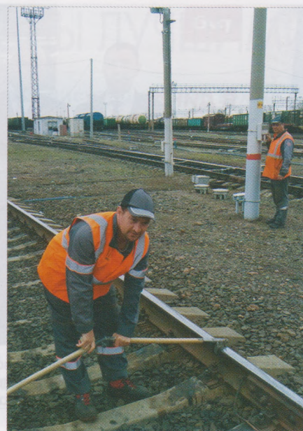
Электромонтер А.А. Пехота, старший электромеханик С.Л. Данилов выполняют проверку шунтовой чувствительности на станции Орск
