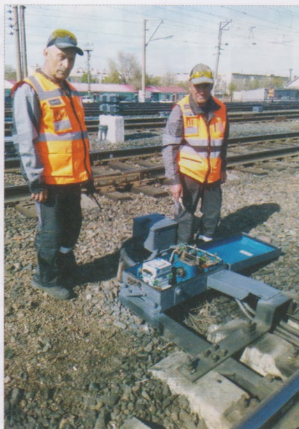
Электромеханик А.П. Шulpин и электромонтер П.Ю. Иванов проверяют внутреннее состояние электропривода на станции Орск
