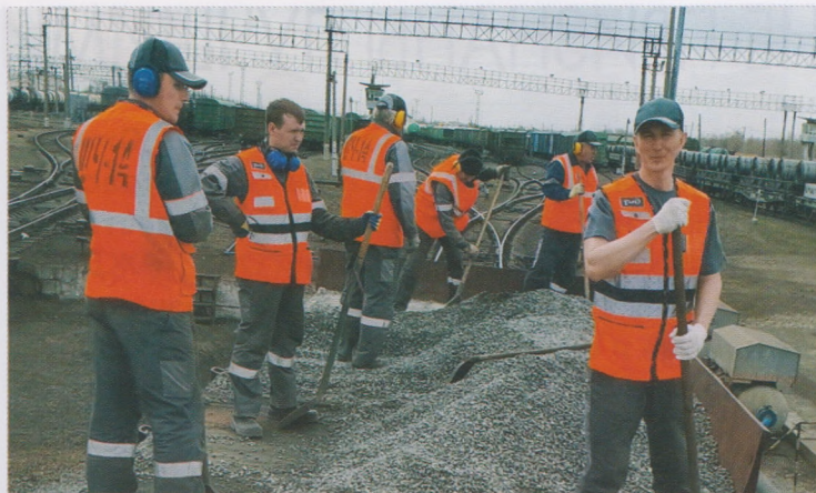
Специалисты горки во время переустройства котлована вагонного замедлителя
