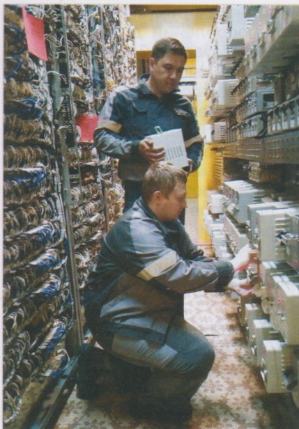
Электромеханики Д.Ф. Булатов и Д.И. Уваров во время замены аппаратуры ТРЦ на посту ЭЦ станции Орск
