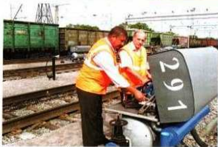
Электромеханик А.П. Лукьянов и старший электромеханик Е.С. Юлеченчук проверяют управляющую аппаратуру замедлителей
