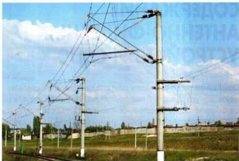
Двухпроводный волновод на электрифицированном участке Волгоград – Разгуляевка
