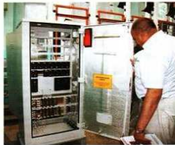
Релейный шкаф, изготовленный Камышловским ЭТЗ
