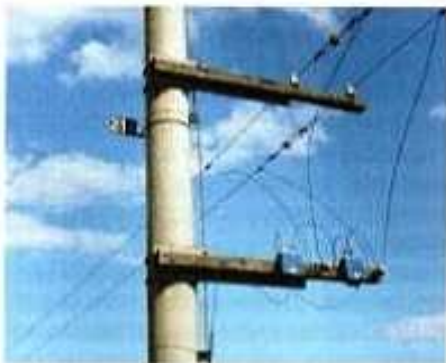
Секционирование двухпроводного волновода
