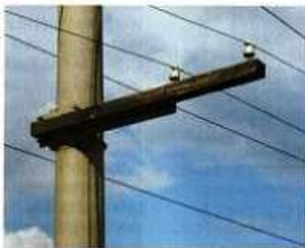
Варианты исполнения двухпроводного волновода на траверсах ТМК 001.02
