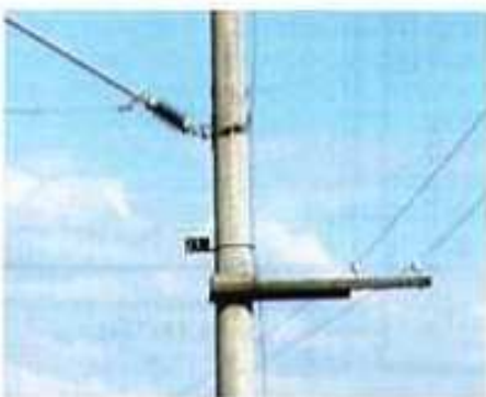
Варианты исполнения двухпроводного волновода на траверсах ТМК 001.02
