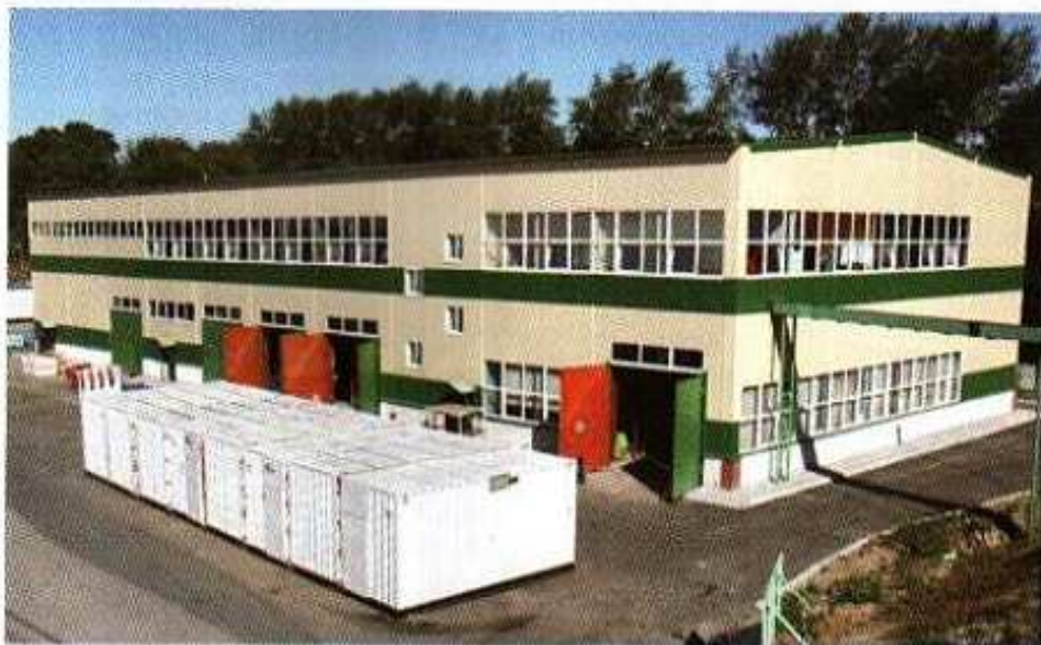
Цех по производству модулей
