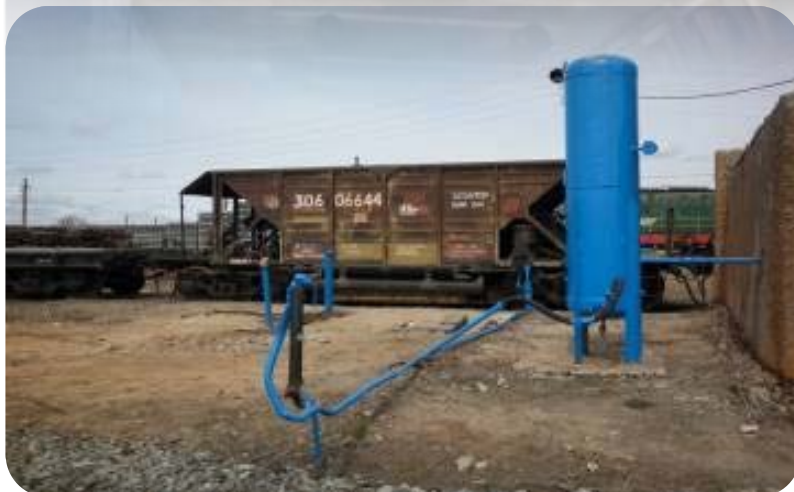
Система компрессорной установки для подачи сжатого воздуха для ремонта и регулировки вагонов ХДВ
