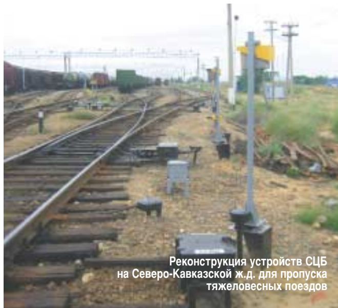
Реконструкция устройств СЦБ на Северо-Кавказской ж.д. для пропуска тяжелых поездов
