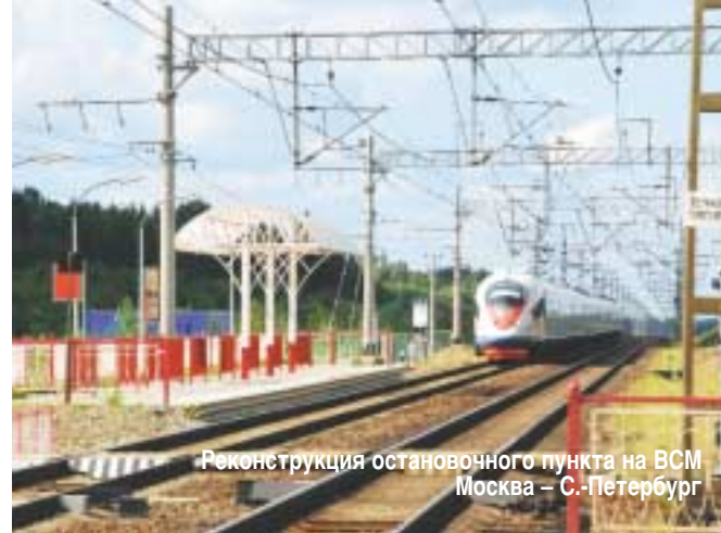
Реконструкция остановочного пункта на ВСМ Москва – С.-Петербург
