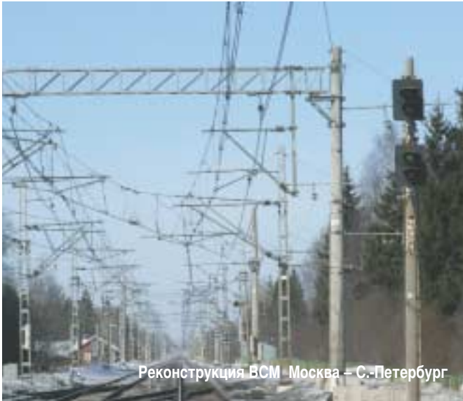
Реконструкция ВСМ Москва – С.-Петербург
