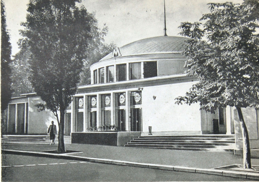
Наземный вестибюль станции «Университет». Общий вид. Архитекторы Г. В. Головки, Б. В. Дзбановский, С. Л. Иванов, М. М. Сыркин.
