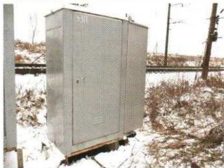
Модуль ТМ-Л для хранения запасного оборудования и инструментов для ремонтно-восстановительных работ
