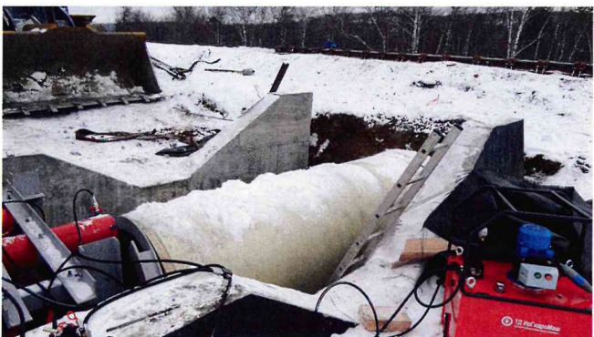
Рис. 4. Прокладка трубы методом неуправляемого продавливания на перегоне Сарбала—Черный Калтан Западно-Сибирской дороги
