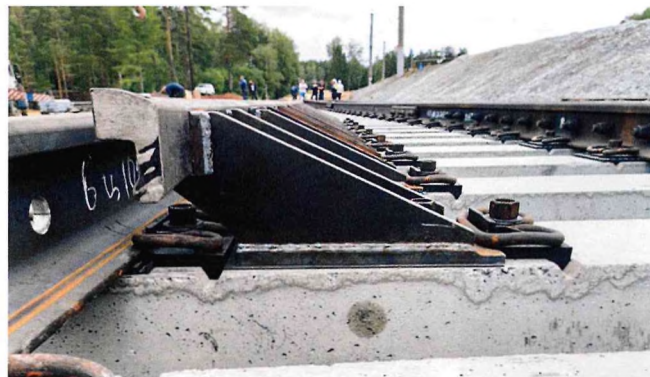
Рис. 7. Контррельсовый узел с раздельным креплением контррельса и ходового рельса
