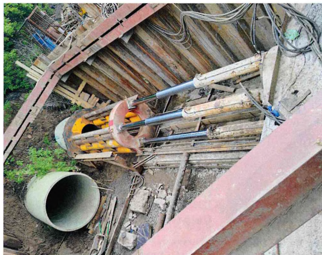
Рис. 5. Продавливание с предварительным бурением лидерной трубы бурошнековой установкой на перегоне Юрга—Таштагол Западно-Сибирской дороги
