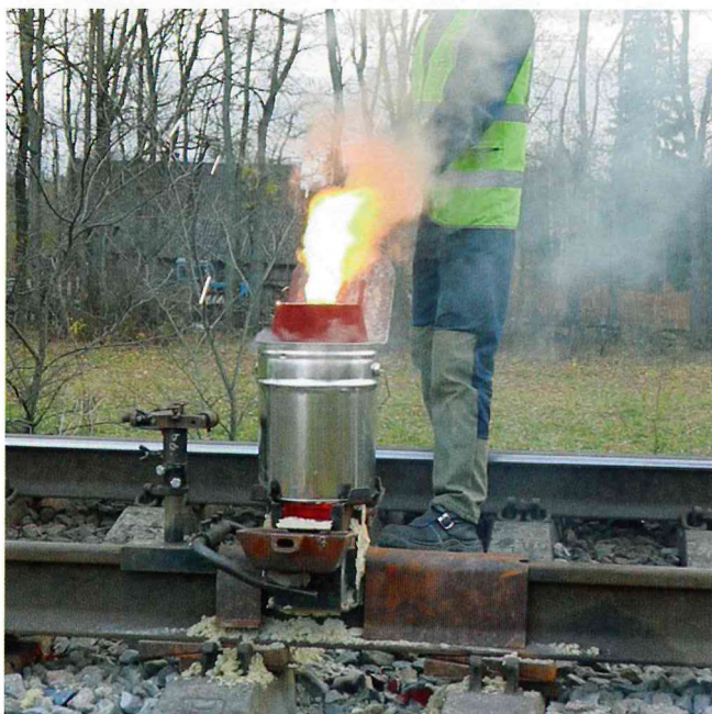
Рис. 4. Заливка термитным металлом выемки, образовавшейся в головке после вырезки дефекта
