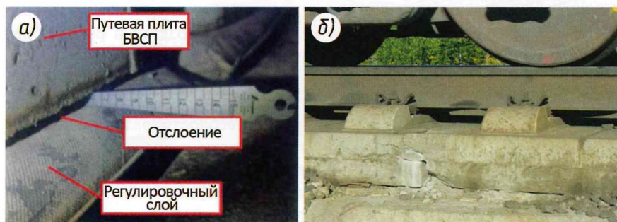
Рис. 1. Отслоение и разрушение регулировочного слоя: а — на ВСМ Китая; б — на Экспериментальном кольце ВНИИЖТа
