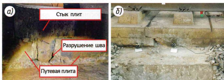
Рис. 2. Нарушение связи между путевыми плитами с их дальнейшим перекосом: а — на ВСМ Китая; б — на Экспериментальном кольце ВНИИЖТа
