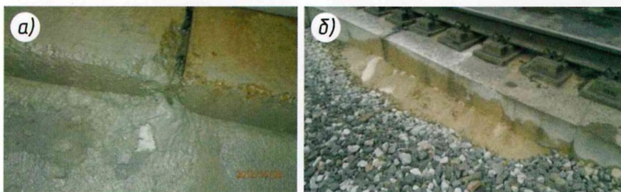
Рис. 6. Выплеск из-под плиты основания: а — на ВСМ Китая; б — на Экспериментальном кольце ВНИИЖТа
