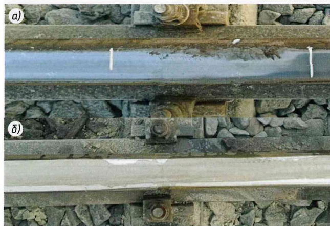
Рис. 6. Головка рельса с дефектом 16.3 (а) и это же место после ликвидации дефекта и наплавки по технологии АТН-2 (б)
