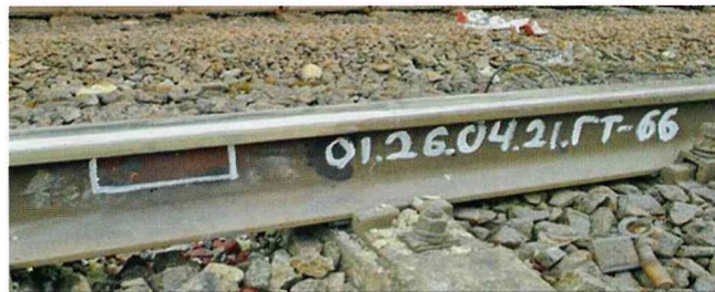
Рис. 5. Результат ремонта рельса по технологии THR (место удаления дефекта и наплавки выделено белой краской — прямоугольник)
