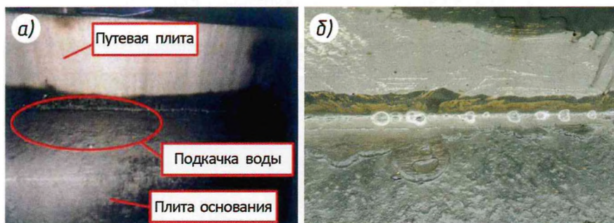
Рис. 4. Просачивание воды на стыке путевых плит и плит основания: а — на ВСМ Китая; б — на Экспериментальном кольце ВНИИЖТа
