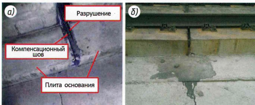
Рис. 5. Разрушение температурного шва: а — на ВСМ Китая; б — на Экспериментальном кольце ВНИИЖТа
