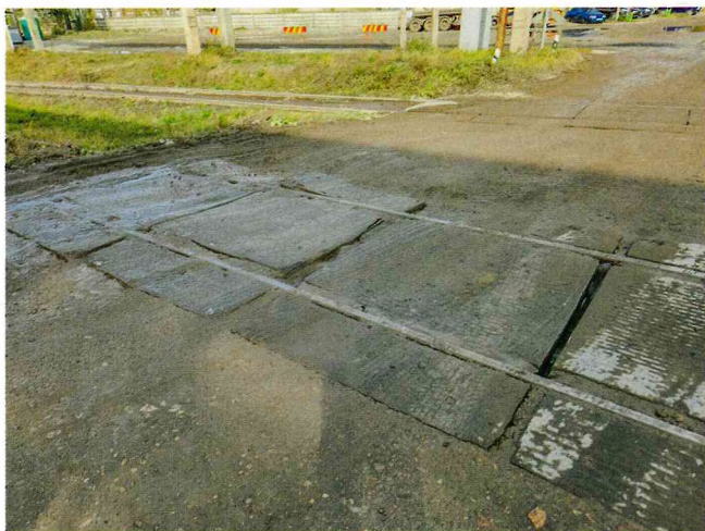
Рис. 1. Деформация настила
