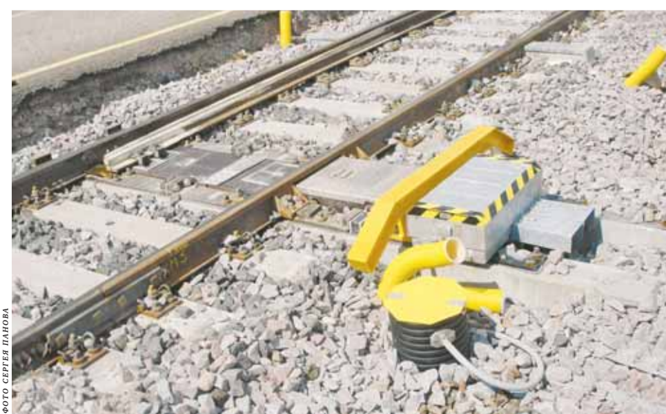
Вот такие стрелочные электроприводы в Финляндии
