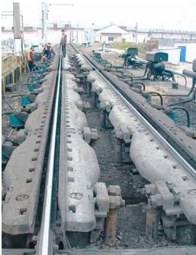
Техническое обслуживание горочного замедлителя на станции Батайск
