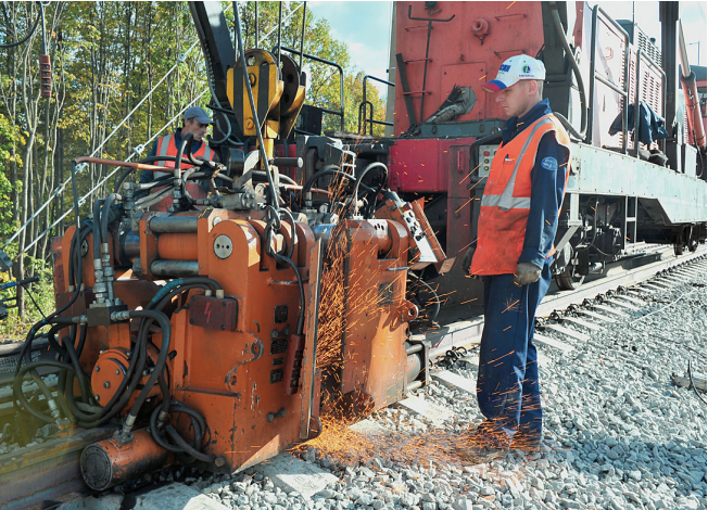
Установку и сварку новых рельсов путейцы производят круглосуточно с применением современной техники
