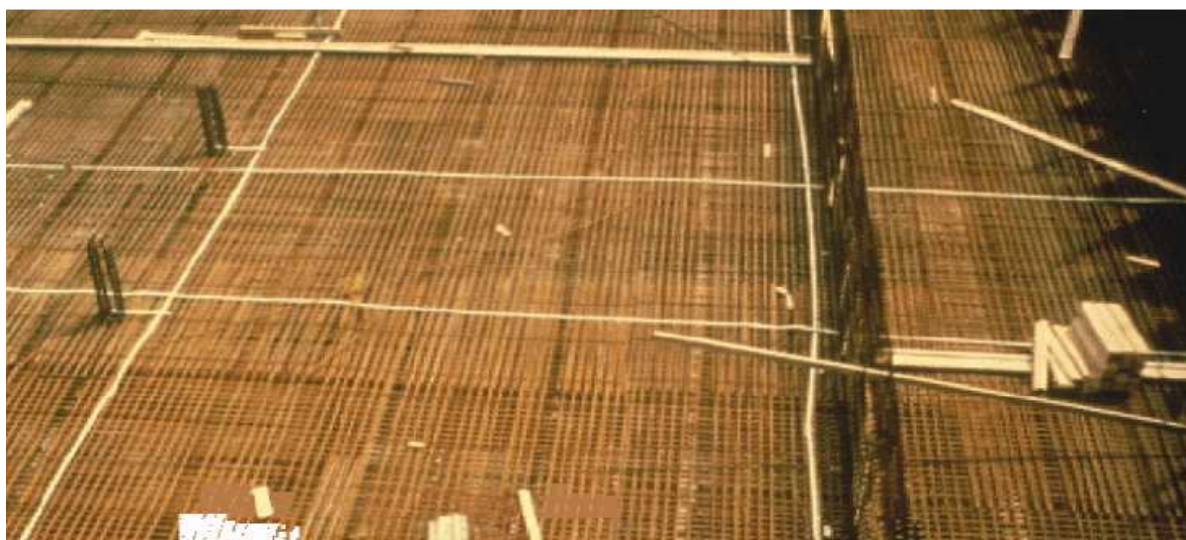
Рис. 16 Пример прокладки заземлителя фундамента (Werkfoto Fa. Dehn)
