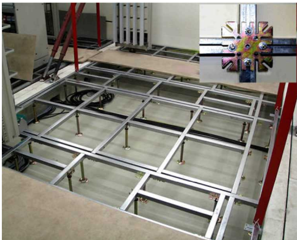
Рис. 29 Опорный каркас фальшпола как решетчатая структура; увеличенное фото: свинчивание в точке пересечения (нижняя сторона)
