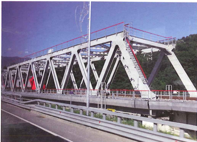
Участок дороги Красная Поляна – Аэропорт
