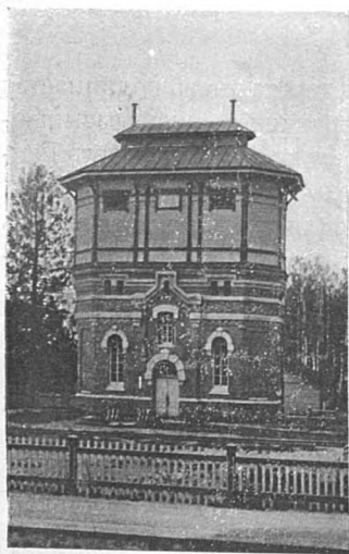
Водоемное зданіе въ 2 бака на ст. Волоколамскъ.
