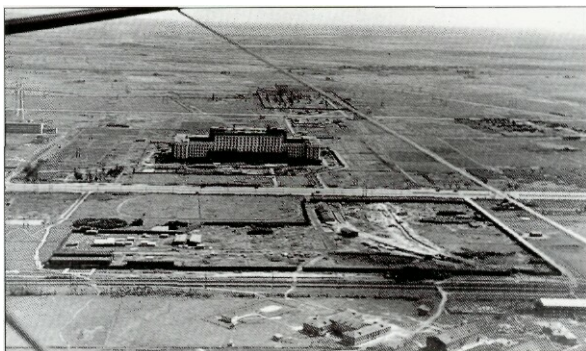
Строительство здания Дома Советов на Московском шоссе. 1939. Фотограф Н. Янов
