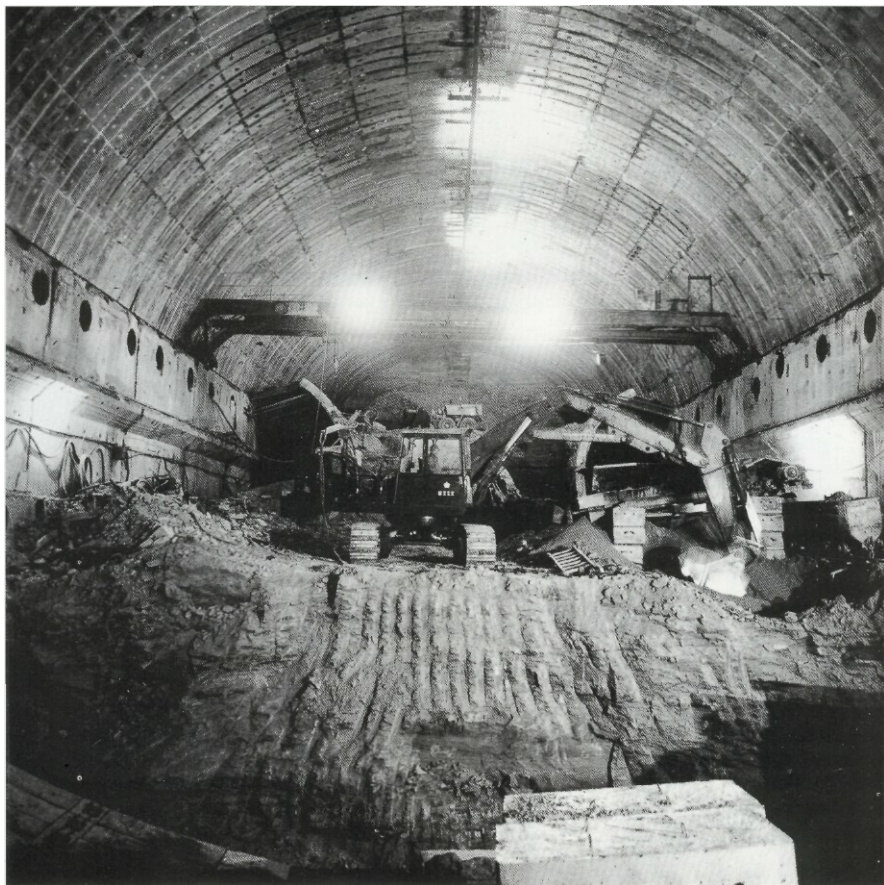
Механизированная разработка породы на двухъярусной станции
