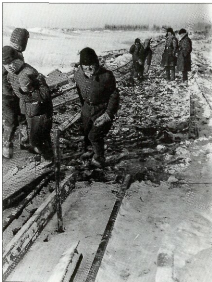
Строительство железной дороги. Ленинград. 27 января 1943 г. Фотограф неизвестен
