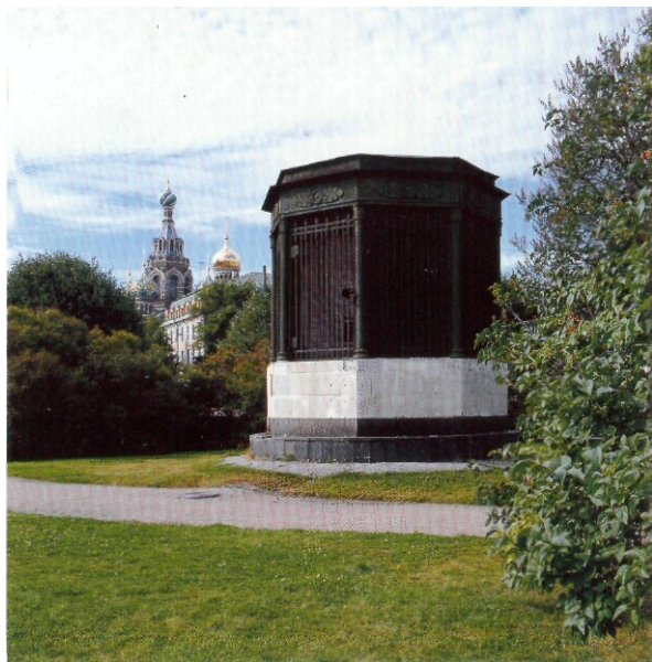
Киоск вентиляционной шахты метрополитена на Марсовом поле. 1995
