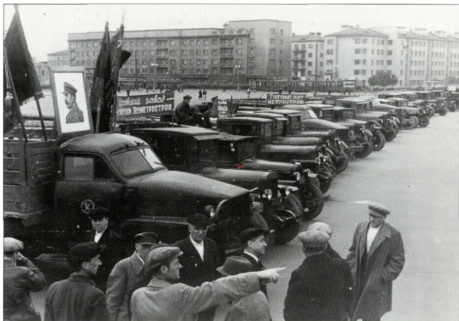
Колонна автомашин у Кировского райсовета перед отправкой на строительство метро. 3 сентября 1947 г. Фотограф И.Баранов
