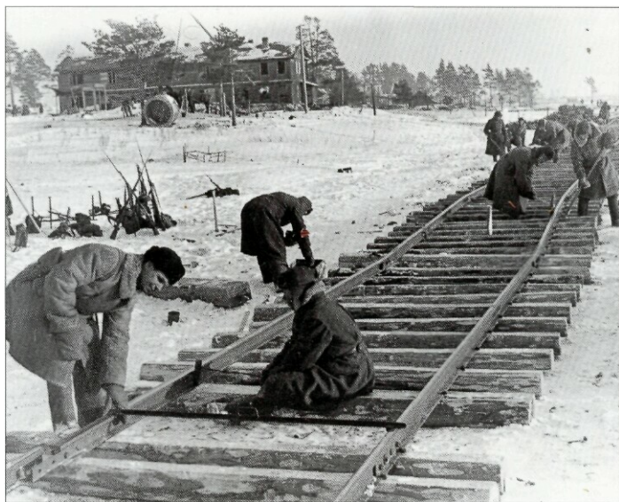
Прикладка дороги в районе Первого рабочего поселка. 1942. Фотограф неизвестен
