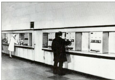
Трехканальный монеторазменный автомат на одной из станций Ленинградского метрополитена.. 1970-е. Фотограф неизвестен
