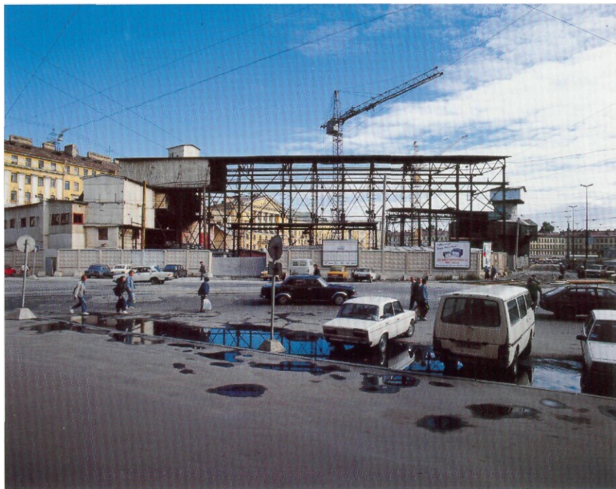
Строительство станции метро „Сенная площадь“
