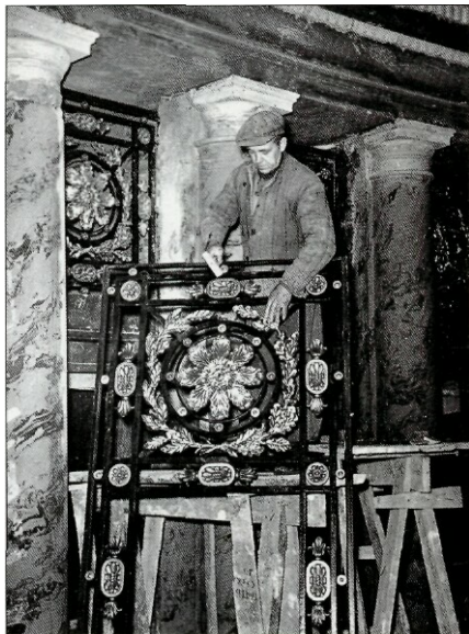
Установка декоративной решетки на станции метро „Автово“. 1955. Фотограф А.Чепрунов
