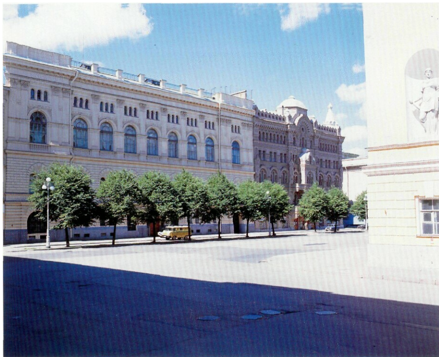
Знание (пл. Островского, д. 7), в котором в течение 50 лет (с 1941 г.) размещалось Управление Ленметростроя. 1995
