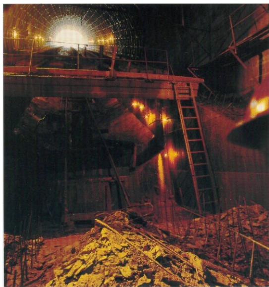
Строительство эскалатора на станции „Спортивная“. 1995
