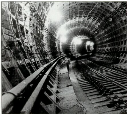
Перегонный тоннель первого участка второй, очереди Ленинградского метрополитена („Парк Победы” - „Технологический институт 2”). 1960. Фотограф Г. Кельх
