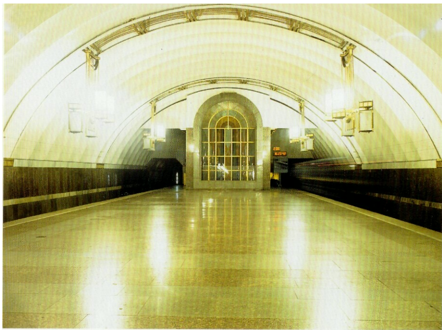
Подземный зал станции метро „Лиговский проспект”. 1995
