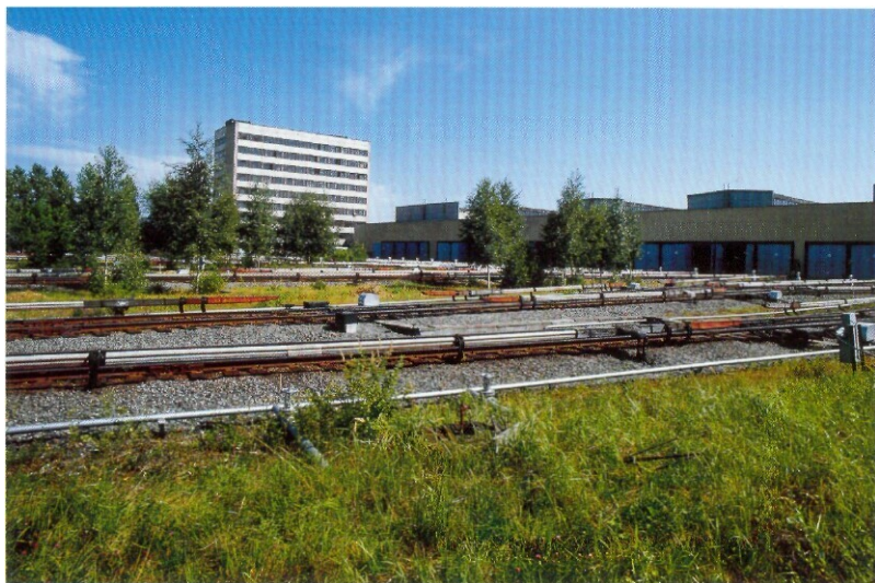
Подъездные пути и административное здание в депо „Московское“. 1995
