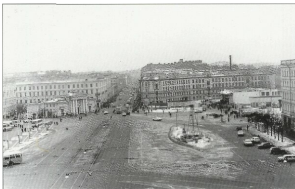
Начало строительства станции метро „Сенная Площадь“
