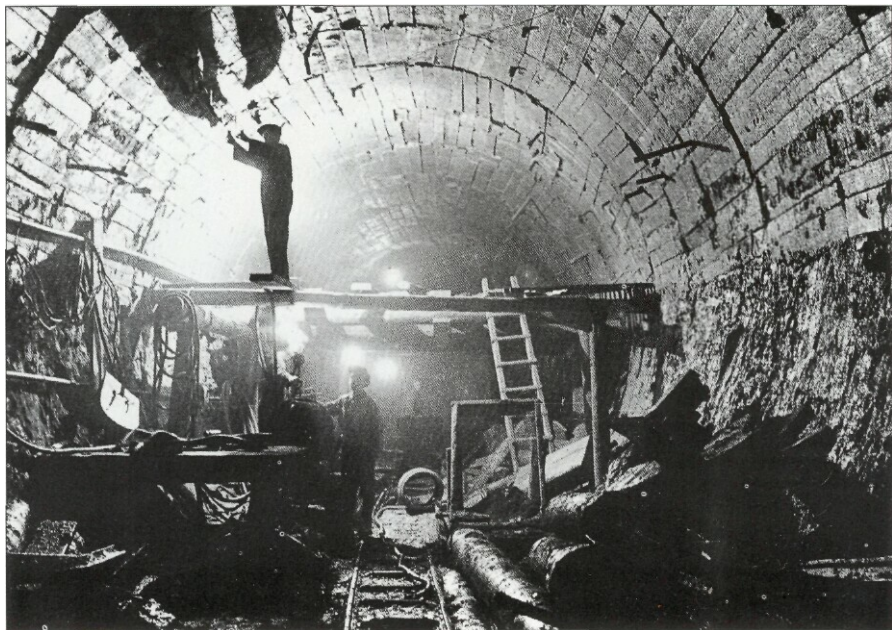
Подготовительные работы по облицовке однопутного тоннеля в шахте № 7-8 Московского метро. 1934. Фотограф неизвестен
