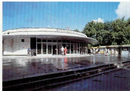
Наземный вестибюль станции метро „Фрунзенская". 1995
