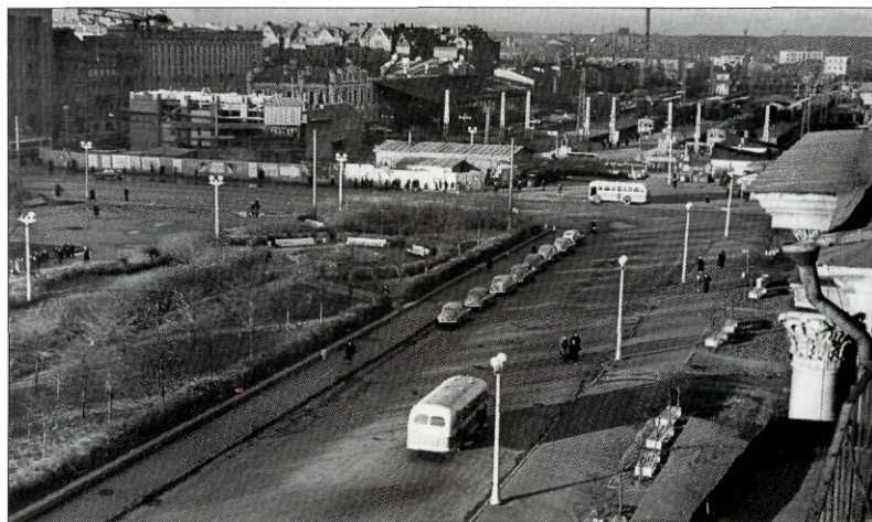
Строительство станции метро и нового здания Финляндского вокзала. 1957. Фотограф С.Лагут
