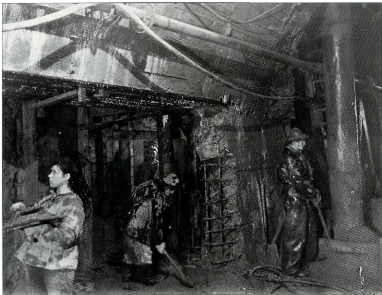
Строительство тоннеля. 1947. Фотограф Л. Михайлов
