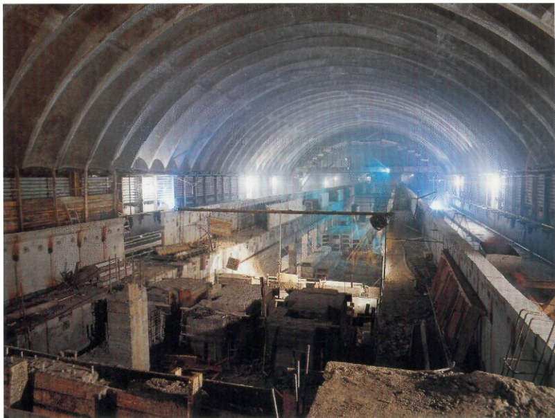
Строительство станции „Спортивная“. 1995
