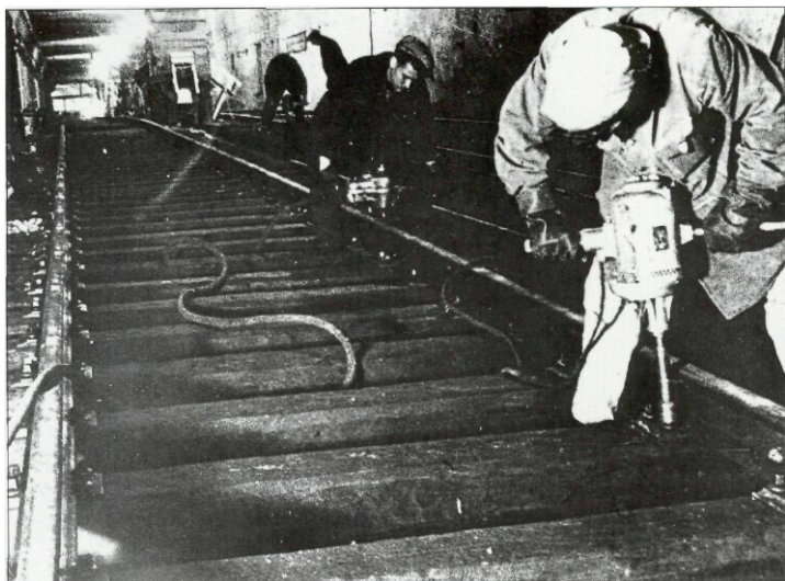
Защивка пути на строительстве метро. 1934. Фотограф неизвестен
