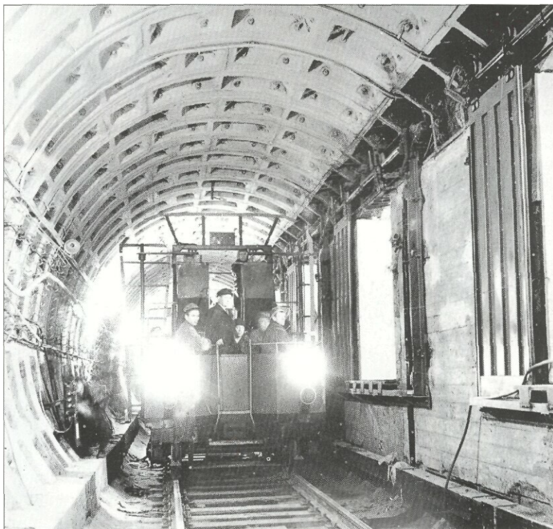
Вплоть до последнего времени по графику, из месяца в месяц, выходила по ночам для контроля за габаритами тоннеля транспортируемая мотовозом „габаритная рама“. На снимке: проверка новой трассы перед пуском в эксплуатацию. 28 сентября 1967 г. Фотограф В.Штейн
