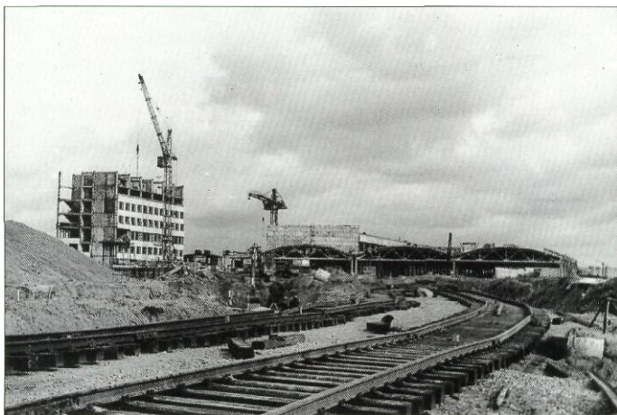
Строительство электродепо „Северное“. 1975—1977. Фотограф В.Дьяконов
