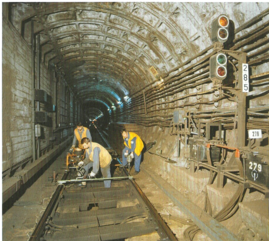
Ремонт пути во время „ночного окна“. 1995
