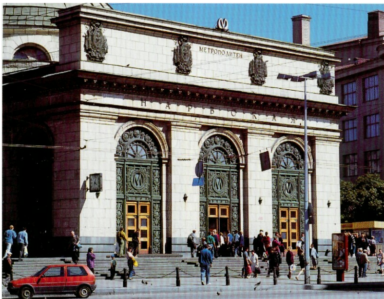
Станция метро „Нарвская”. 1995
