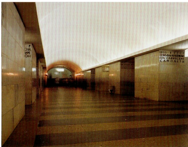
Станция метро „Технологический институт 2“. 1995
