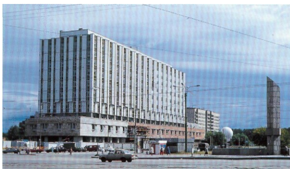
Новое здание метрополитена — инженерный корпус, (Дом связи) в районе станции метро „Приморская“. 1995
