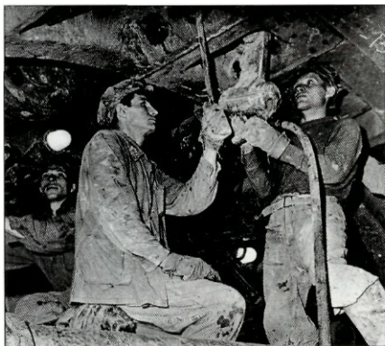
Проходческие работы под руслом Невы: установка очередного тубингового кольца. 9 июня 1962 г. Фотограф С. Григорьяни
