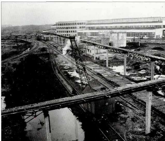
База ремонта метрополитена на площадке „Автово“. Ноябрь 1970 г. Фотограф Кузькин
