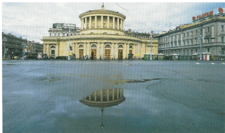
Станция метро „Площадь Восстания“. 1995
