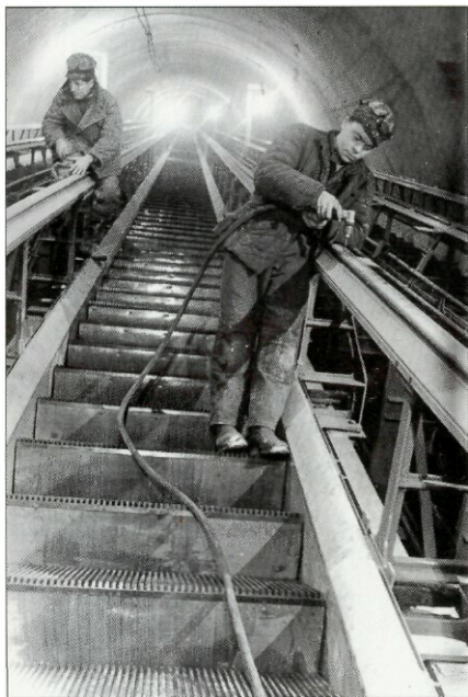
Монтаж эскалаторного устройства на станции „Нарвская”. 1954-1955. Фотограф Д.Трахтенберг
