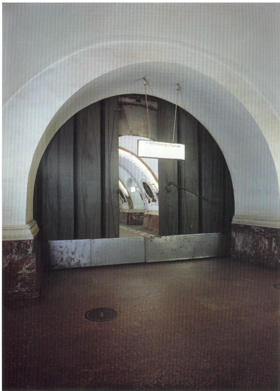
Затвор, отделяющий наклонный ход эскалаторов от станционного зала. 1995
