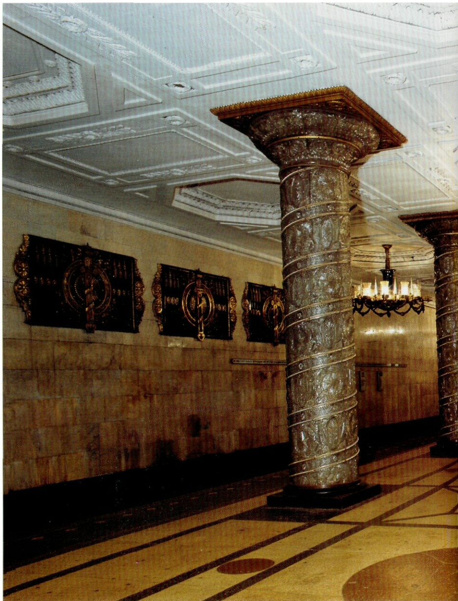
Центральный подземный зал станции метро „Автово“. 1995
