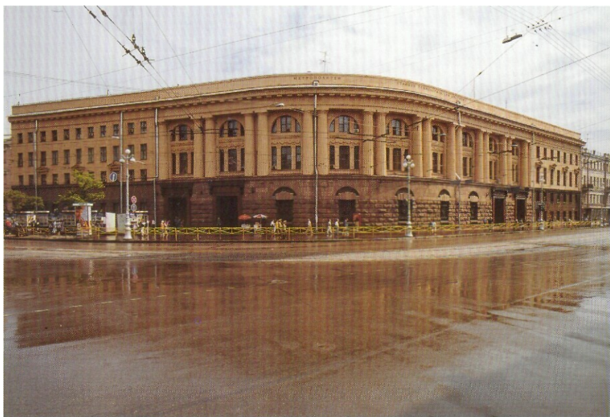
Здание Управления метрополитена (Московский пр., 28). Здесь размещаются диспетчерские службы, технические средства связи, вычислительный центр, отделы управления и т.д. /1995
