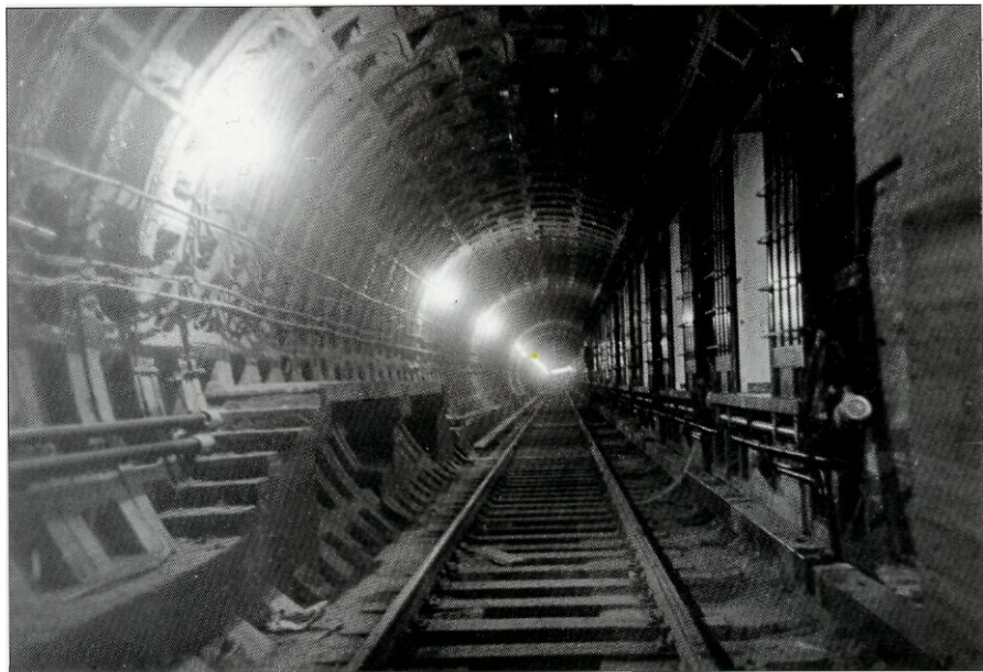
Тоннель в районе станции метро „Елизаровская“. Декабрь 1970 г. Фотограф М.Ширман
