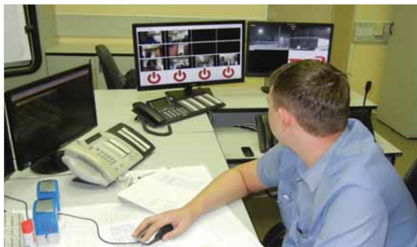
Рабочее место дежурного по станции, оснащенное цифровыми мультисервисными пультами с функциями видеоконференцсвязи и видеонаблюдения
