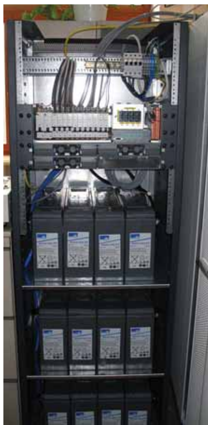
Герметизированные аккумуляторы серии Sonnenschein A412/120 FT с желеобразным электролитом
