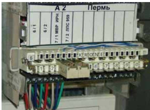
Размещение элементов защиты в кроссах
