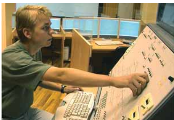
Рабочее место дежурного по станции, оборудованной релейными системами ЭЦ
