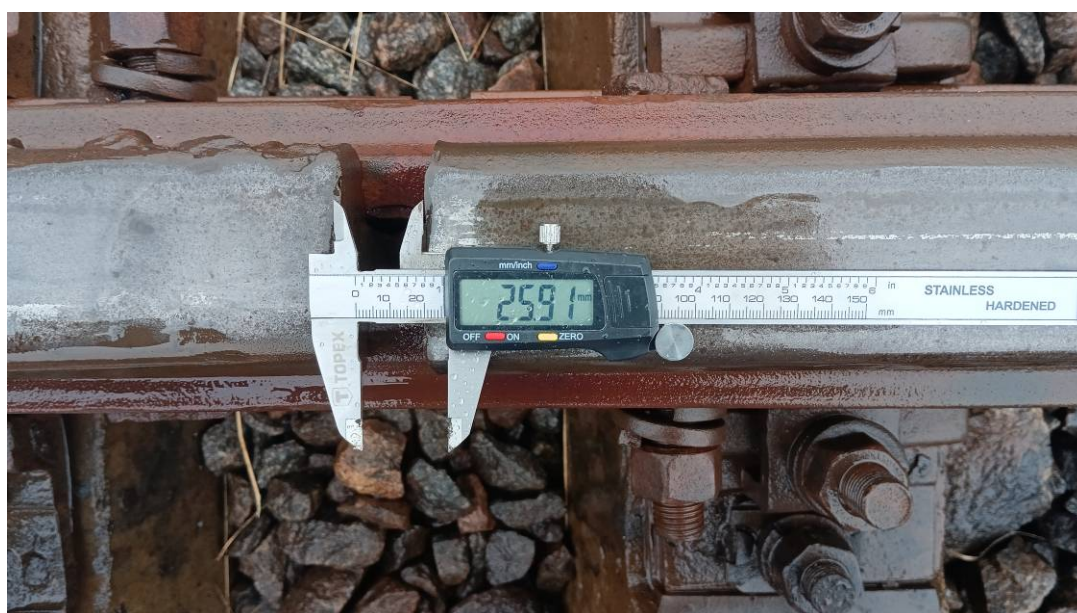
Рис. 2 - Понаднормативний зазор у стикі рейки підхідної колії з рейкою колії платформи вагонних ваг
