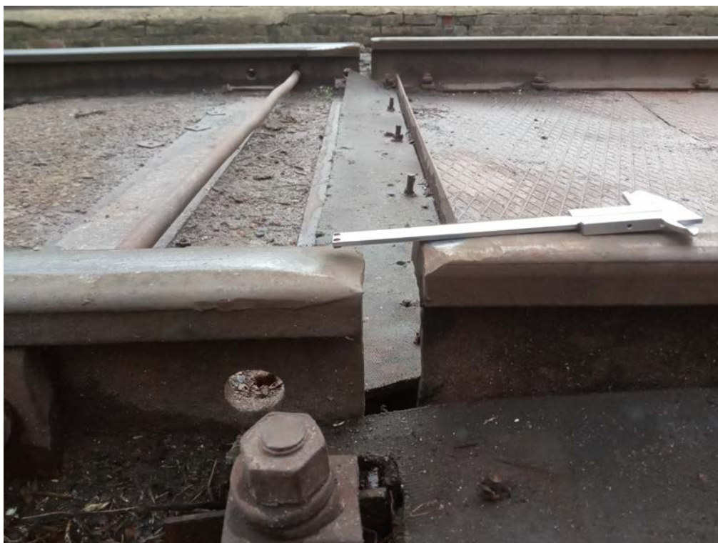
Рис. 1 - Понаднормативний вертикальний уступ в стиках рейок підхідних колій з колією платформи вагонних ваг
