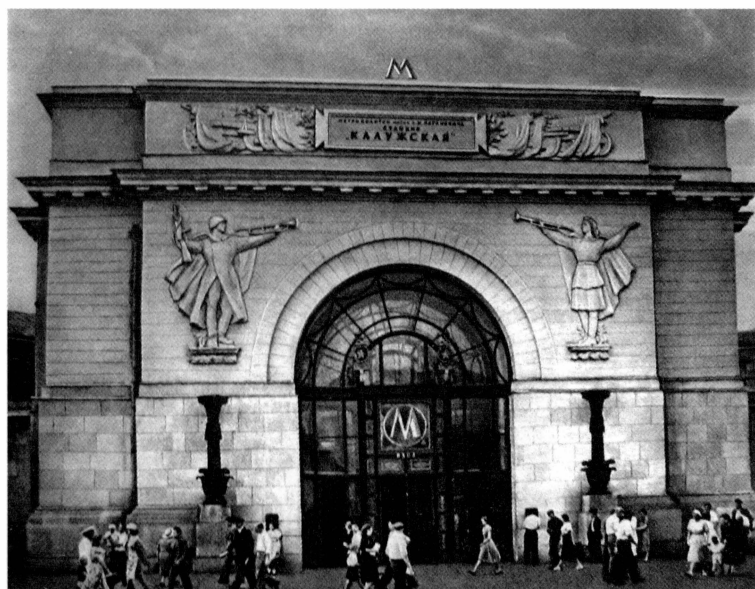
Ст. Калужская. Вид наземного вестибюля
