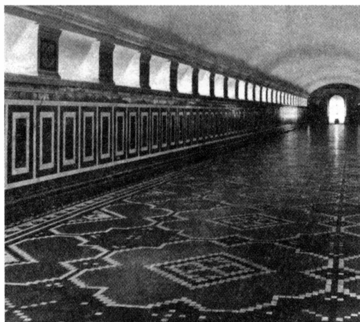
Ст. Курская. Вид перехода с плиточным покрытием пола в виде ковра.
