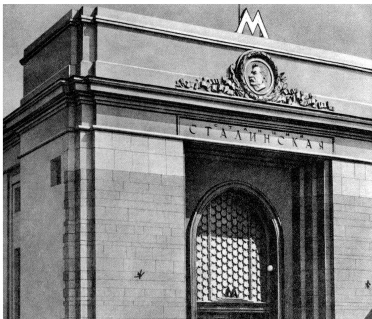
Ст. Сталинская. Фрагмент наземного вестибюля.
