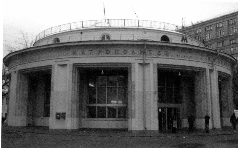
Ст. Новокузнецкая. Внешний вид наземного вестибюля.
