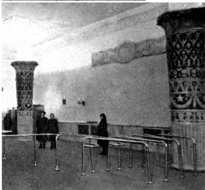
Ст. Ботанический Сад. Интерьер наземного вестибюля. Колонны, покрытые майоликой, и гипсовый барельеф И.В.Сталина.
