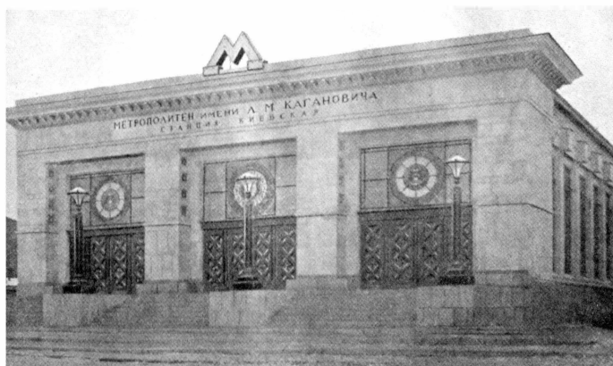
Ст. Киевская. Вид наземного вестибюля.
