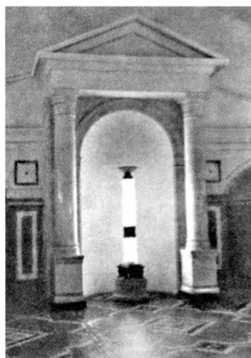
Ст. Курская. Фрагмент перехода.
