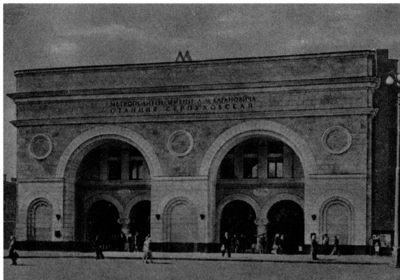
Ст. Серпуховская. Вид наземного вестибюля.
