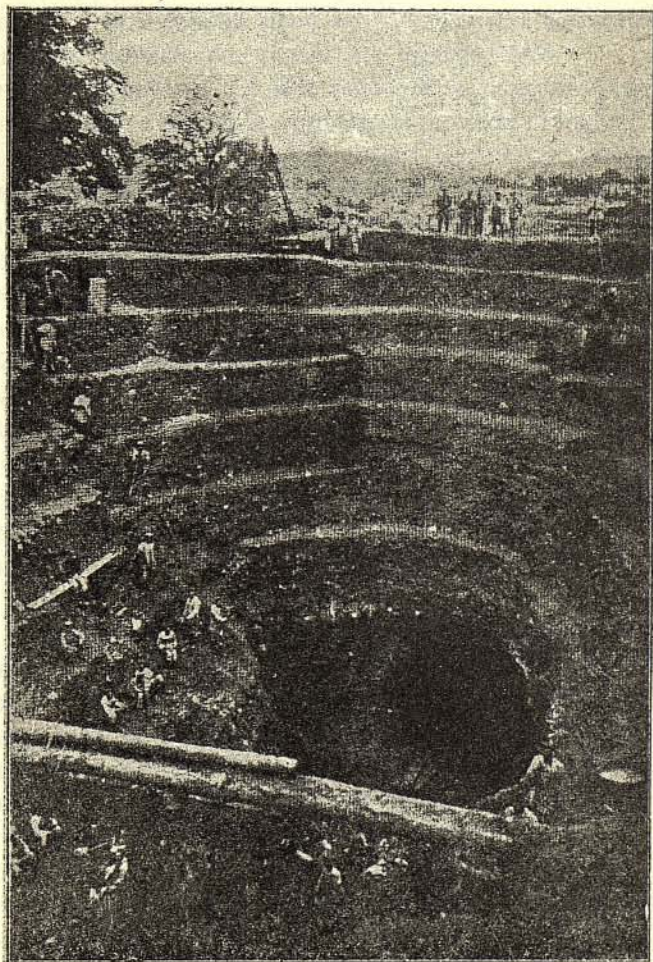
Фотография 29. Восстановление туннеля у Мохон посредством срытия земляных масс, лежащих над местом взрыва. Выполнено 9-й и 15-й ж.-д. строительными ротами и тремя ротами 3-го железнодорожного рабочего батальона.
