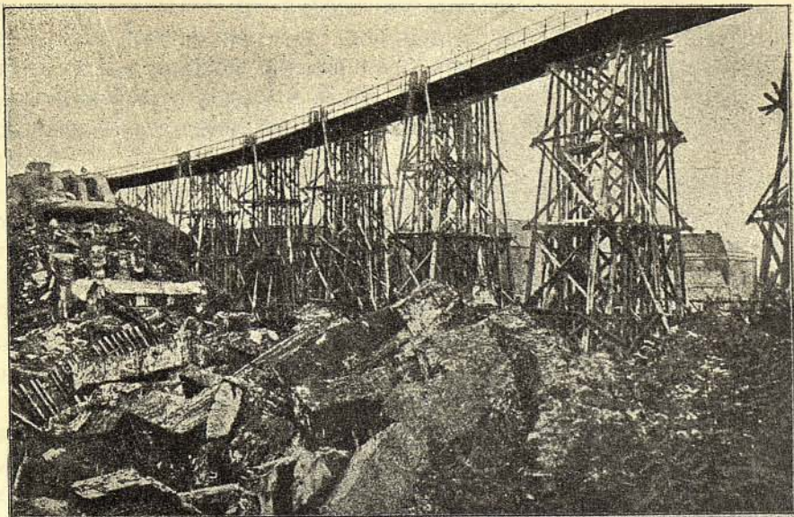
Фотография 38. Восстановленный мост у Фурми. На переднем плане обломки старого моста; на заднем — построенный 25-й ж.-д. и 20-й резервной ж.-д. строительными ротами временный мост.
