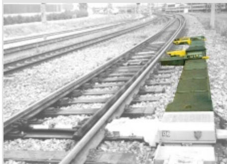
Обычная, установленная сбоку, механическая система тяг и рычагов для передачи сил перевода
