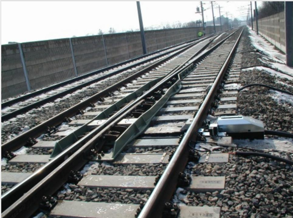
ÖBB; EW60-1200-1:18,5 с HYDROSTAR® НВ, использование на основном направлении
