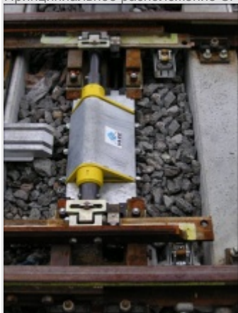
SPHEROLOCK®, смонтированный на стальной лотковой шпале
