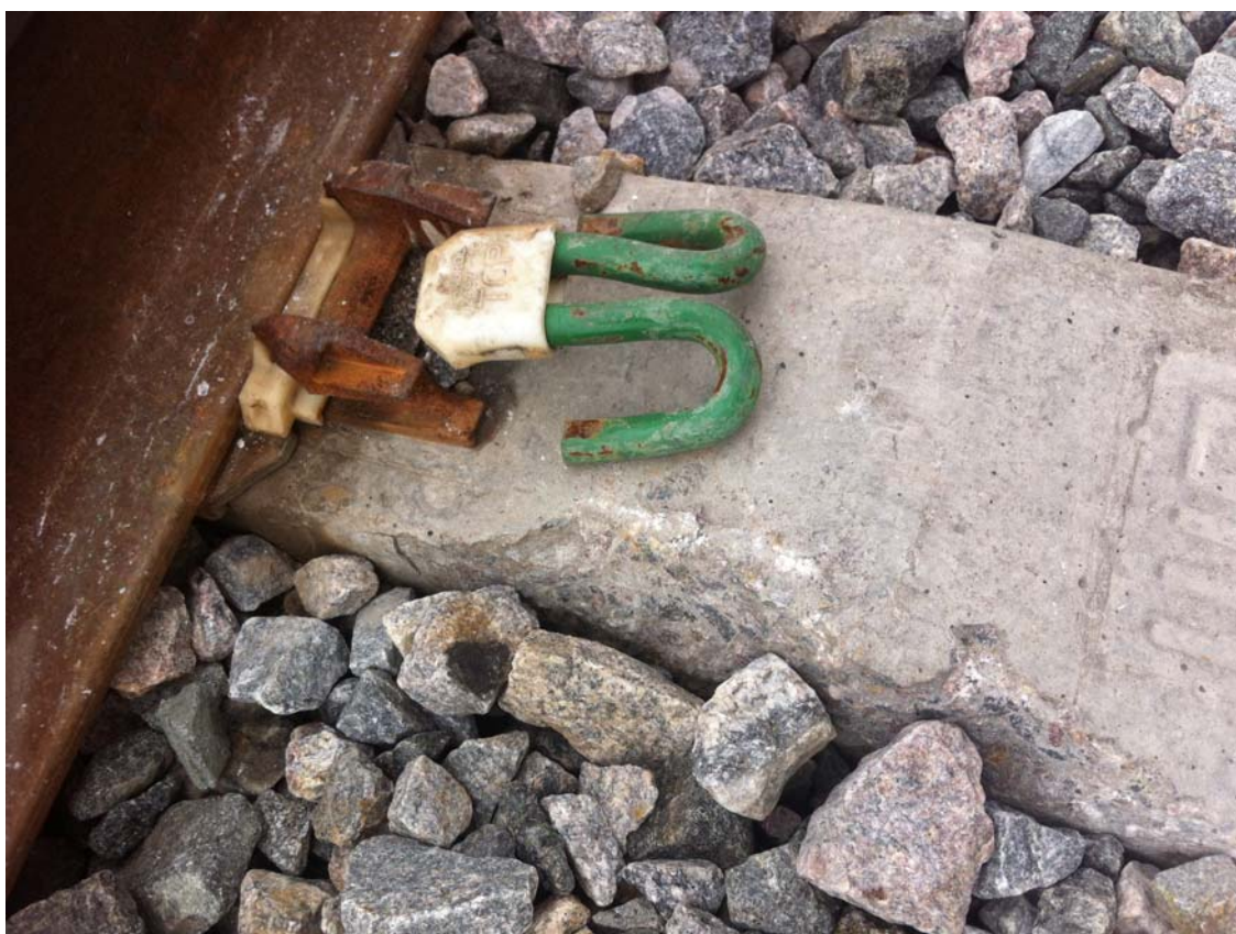
Рисунок 8. Следы на шпале от воздействия выправочно-подбивочной машины.
