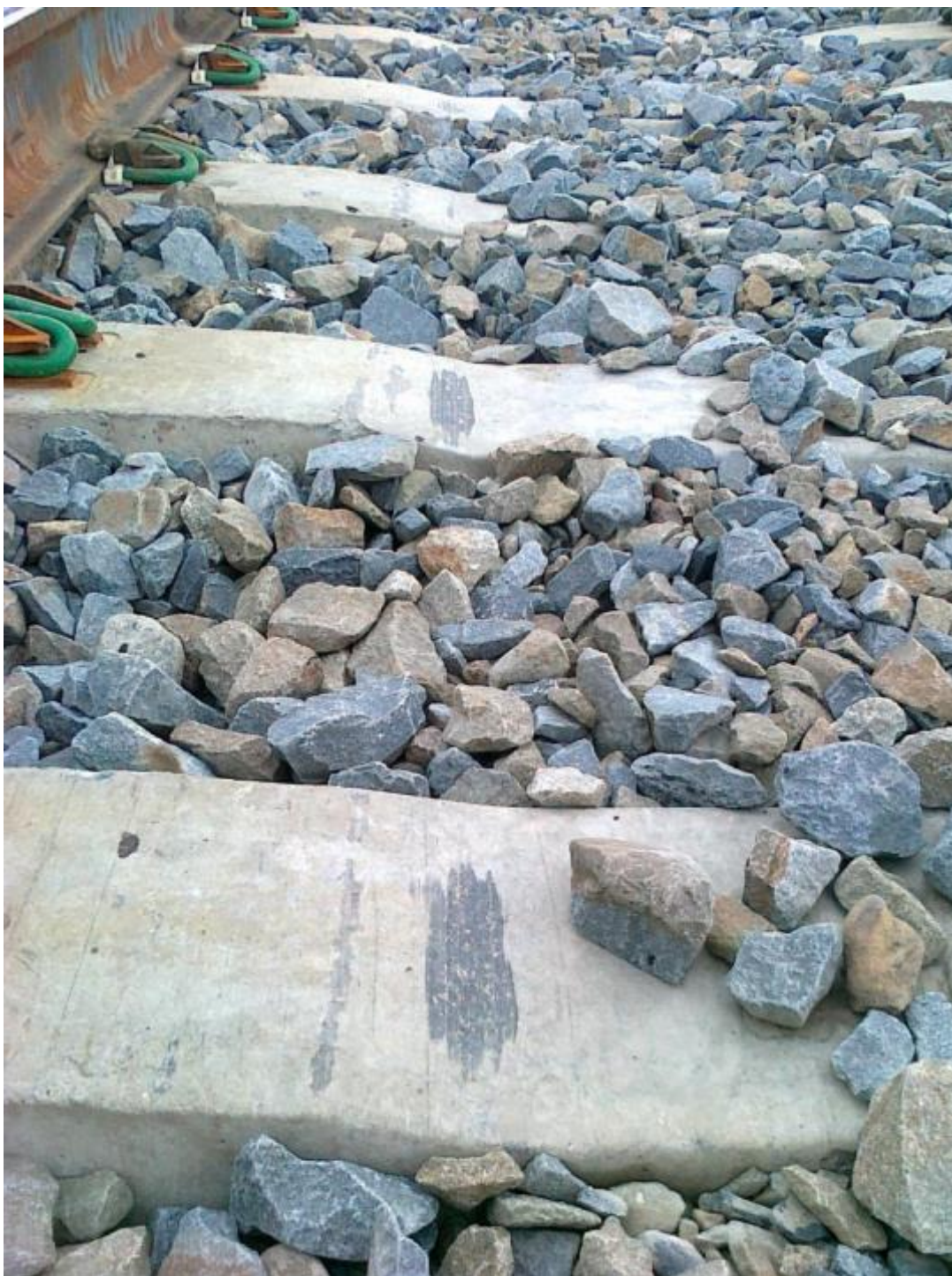
Рисунок 9. Следы на шпалах от планировщика балласта.
