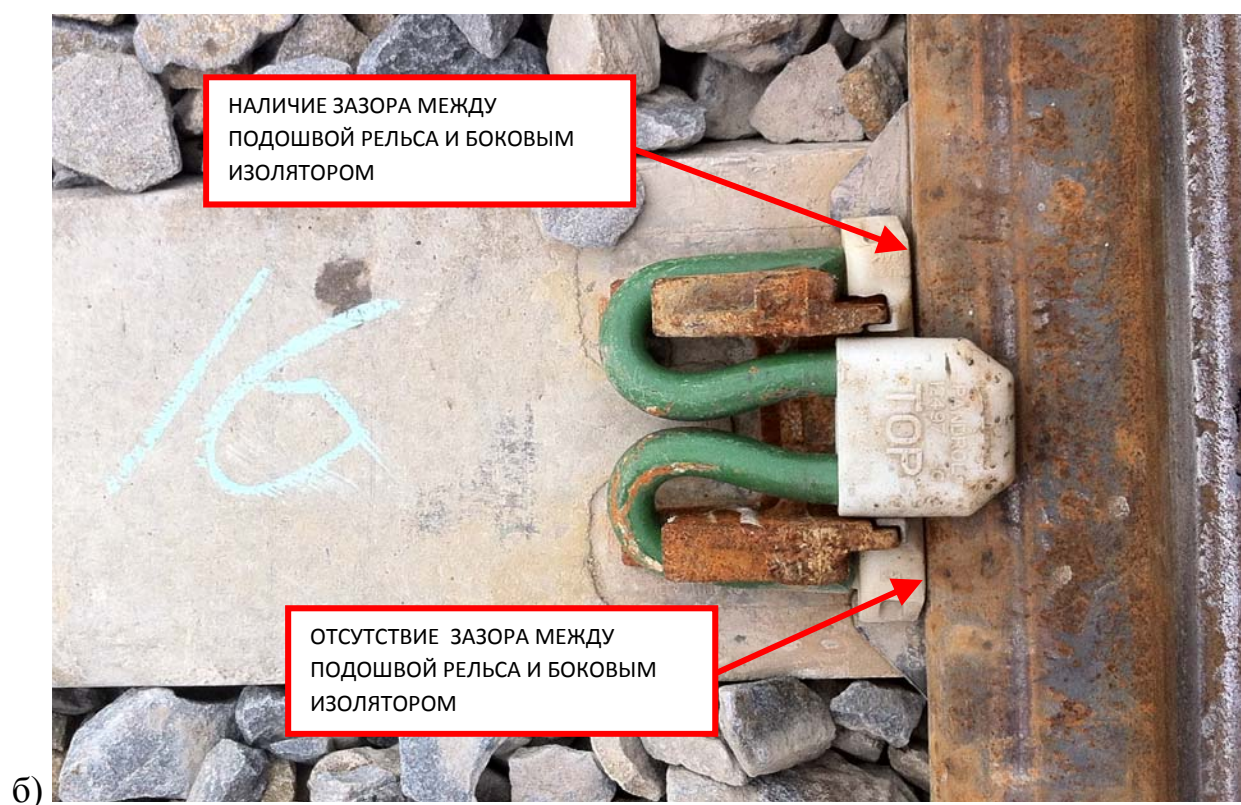
Рисунок 10. Перекос шпал.
