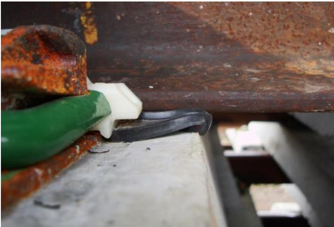
Рисунок 5. Прокладка лежит на шпале ее буртиком.
