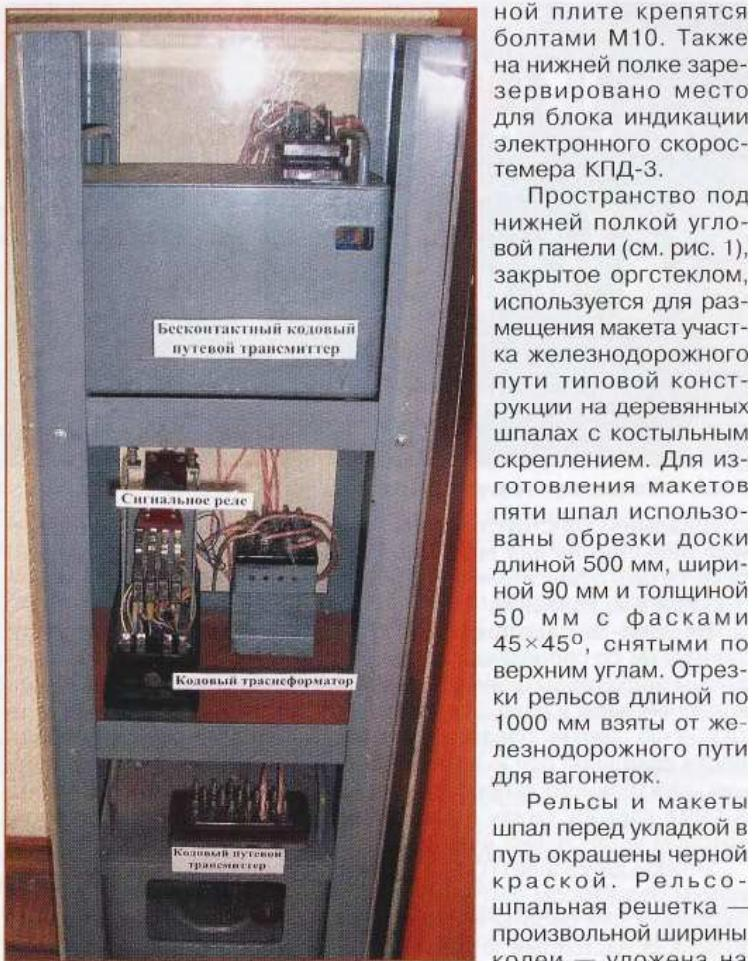
Рис. 2. Стойка релейного шкафа сигнальной точки автоблокировки
